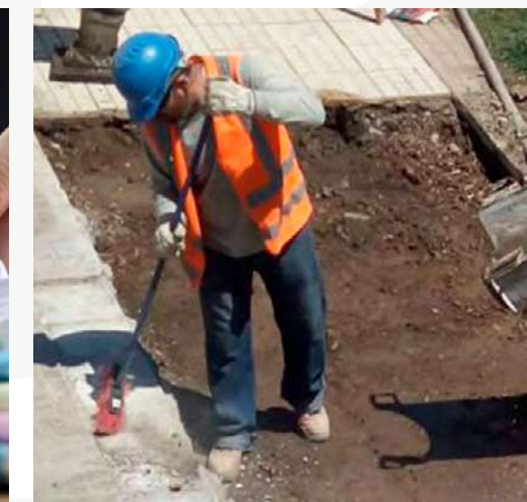
Ejecución de obras
