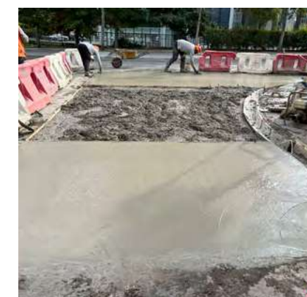
Pavimentación y Aguas Lluvias SERVIU y MOP
