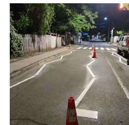
Obras de señalización y demarcación
