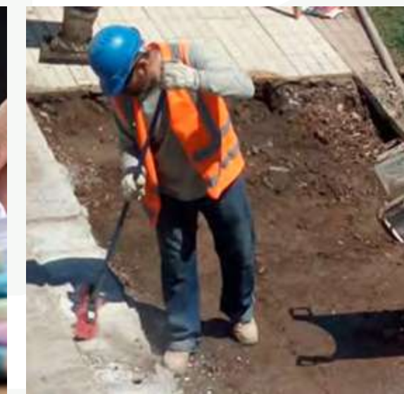
Ejecución de obras
