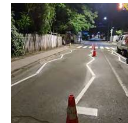
Obras de señalización y demarcación
