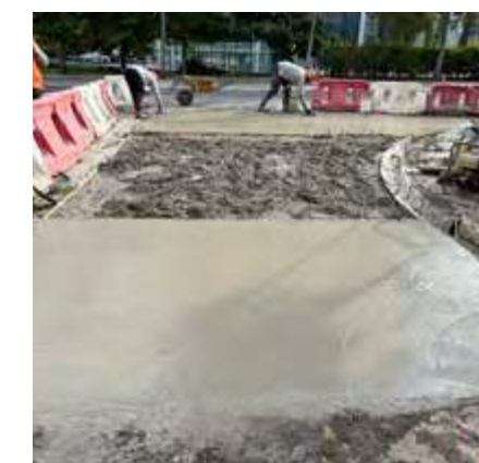
Pavimentación y Aguas Lluvias SERVIU y MOP
