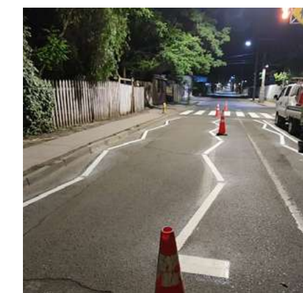
Obras de señalización y demarcación
