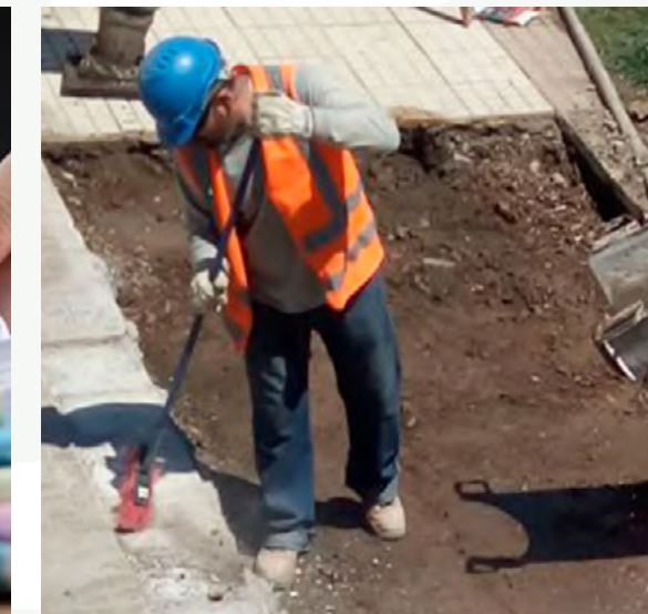
Ejecución de obras
