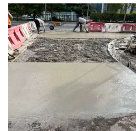
Pavimentación y Aguas Lluvias SERVIU y MOP
